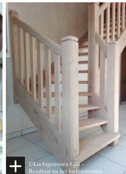
+ ©Luchtgommen Cilli - Met luchtgommen ontdoe je een trap snel en eenvoudig van oude afwerkingslagen
